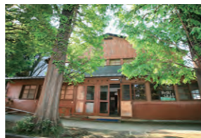
旧第一体育館
